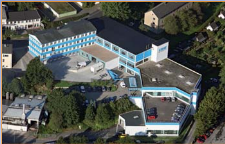
■ Imposant: Die Gebäude sind komplett renoviert worden.
